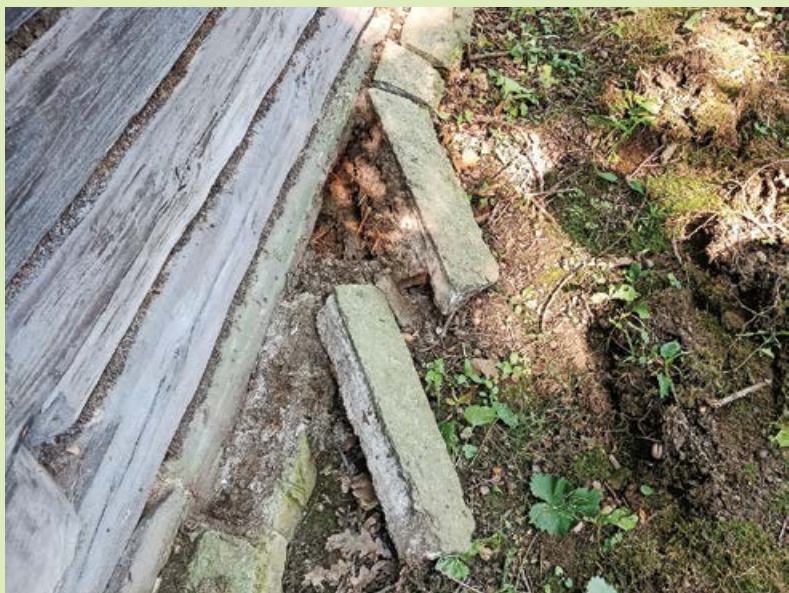
Stav spodních trámů a zídky před rekonstrukcí. Ta spočívala ve výměně poškozených trámů a obnovení kamenné podezdívky po obvodu.
