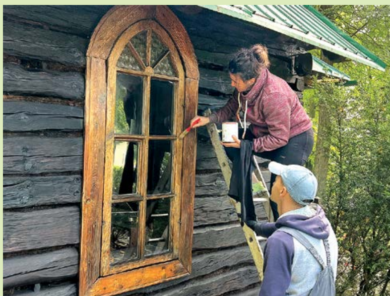
Všechny práce byly prováděny ručně, napuštění a nakonzervování následovalo po očištění a sanaci dřeva a likvidaci dřevokazného hmyzu. (Foto: Jiří Matýšek)
