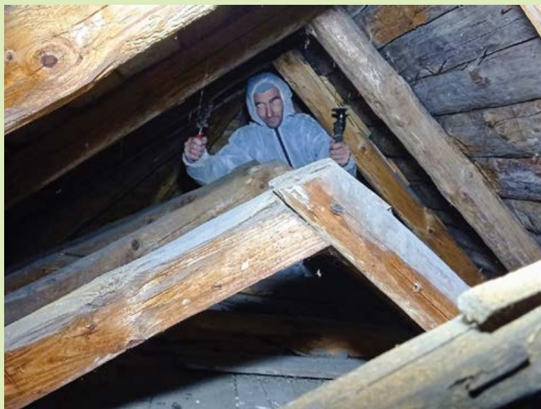
Práce v ochranném oděvu při ošetření a sanaci ve stísněném prostoru uvnitř věžičky v podkroví
