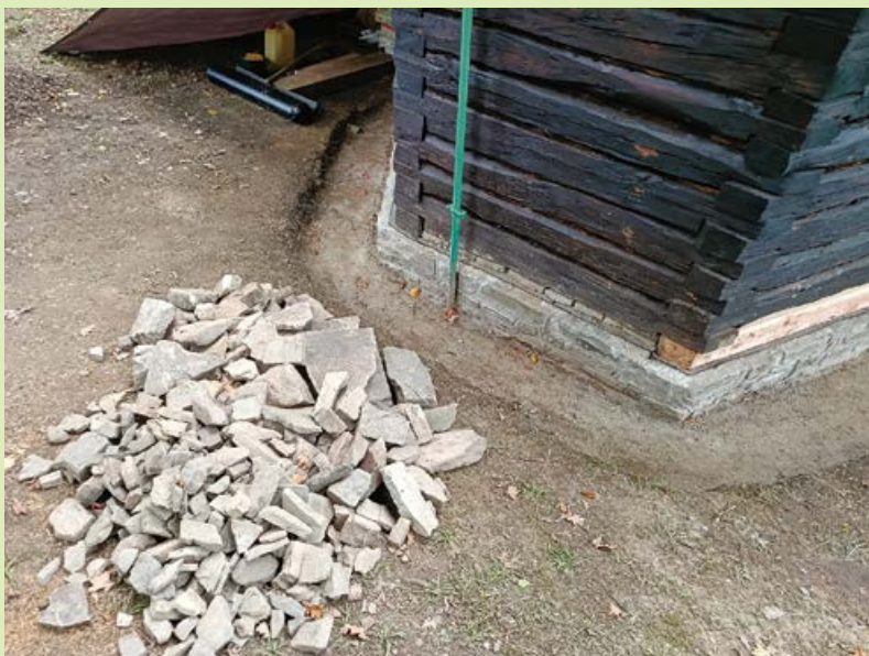
Obnovená kamenná podezdívka s ručně tesanými trámy a štípaným kamenem. Zemina je odhrnutá kvůli lepšímu odvodu vlhkosti.
