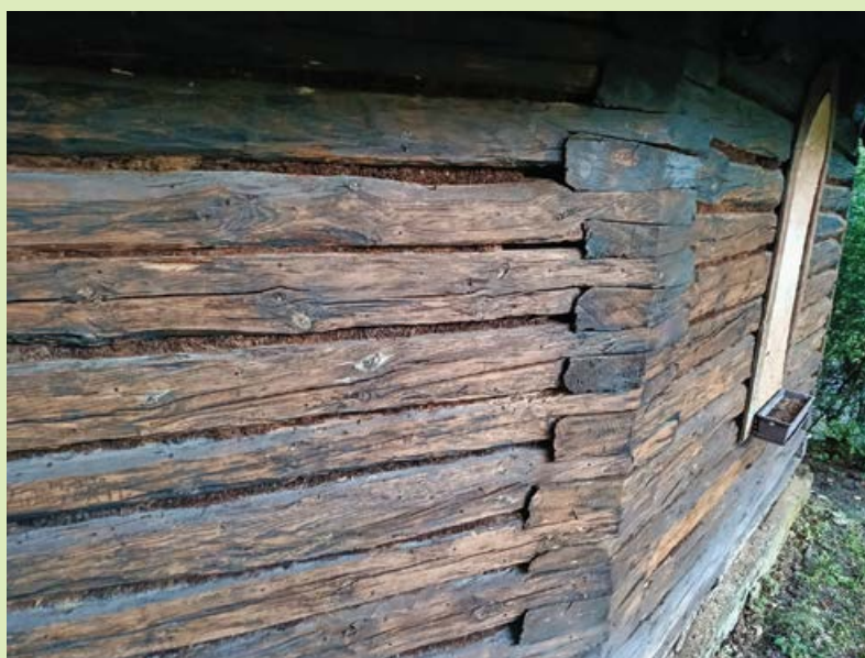
Původní stav kaple před rekonstrukcí
