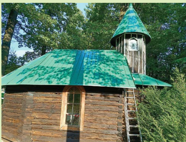
Kaple po čištění, připravená na ošetření
