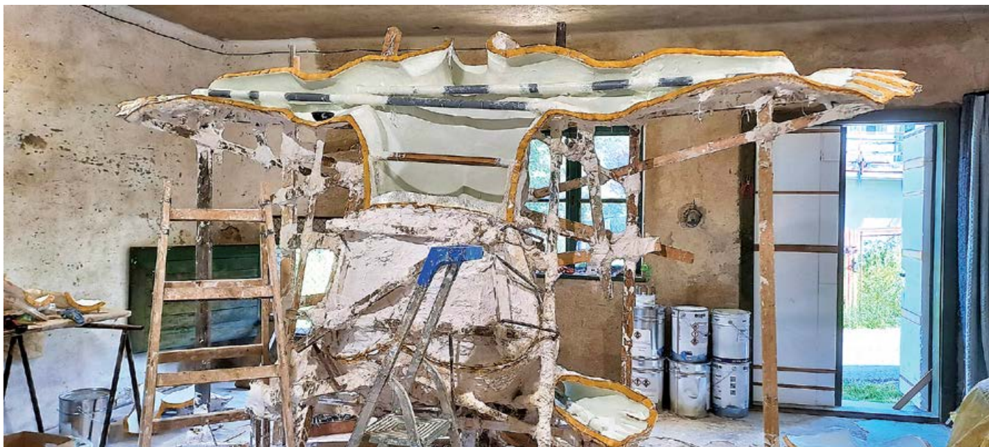
Obr. 11: Laminování – postupné skládání dílů, vnitřní konstrukce z plastových trubek. Odlitek je tvořen skořepinou o síle asi 5 mm.
