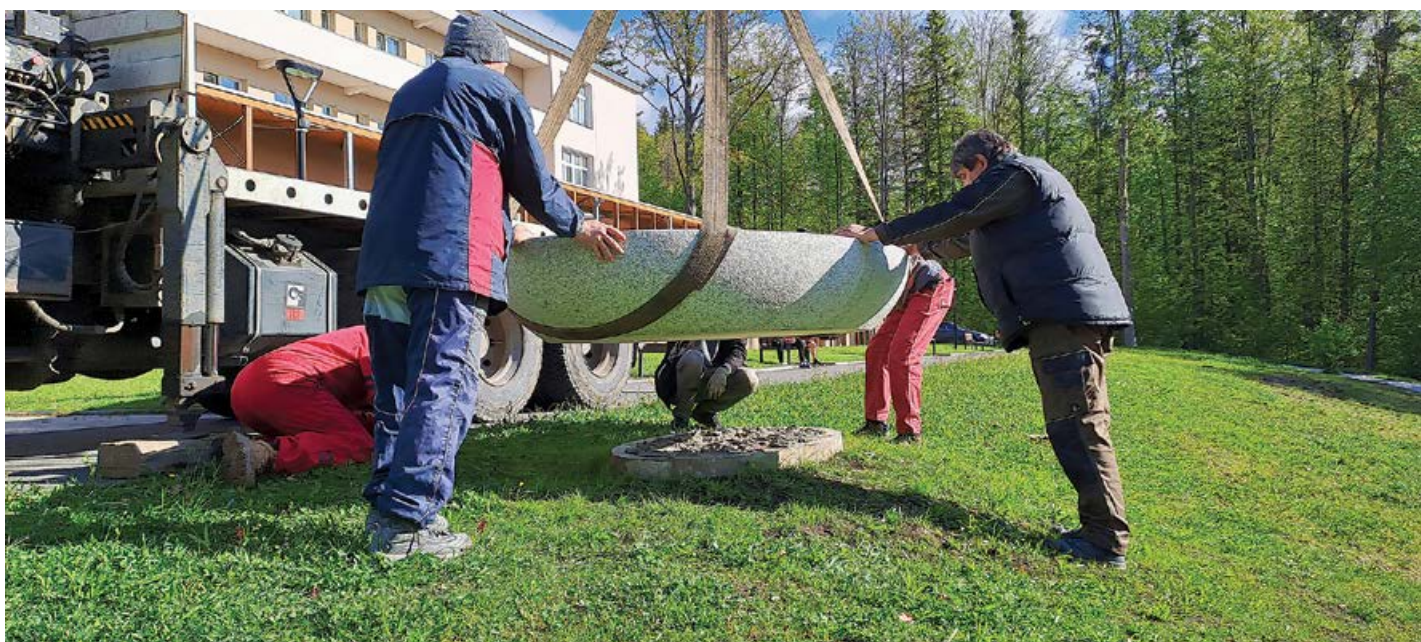
Obr. 27, 28: Výroba podstavce ze žuly (granitu). Obr. 29: Osazení podstavce.
