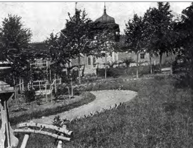
Budova s názvem Koupelna (postavená 1902) v roce 1904. Dnes jsou zde Lázně s rehabilitačním bazénem, koupelemi, bahenními zábaly, elektroléčbou a s pracovišti fyzioterapeutů - na snímku vpravo.
